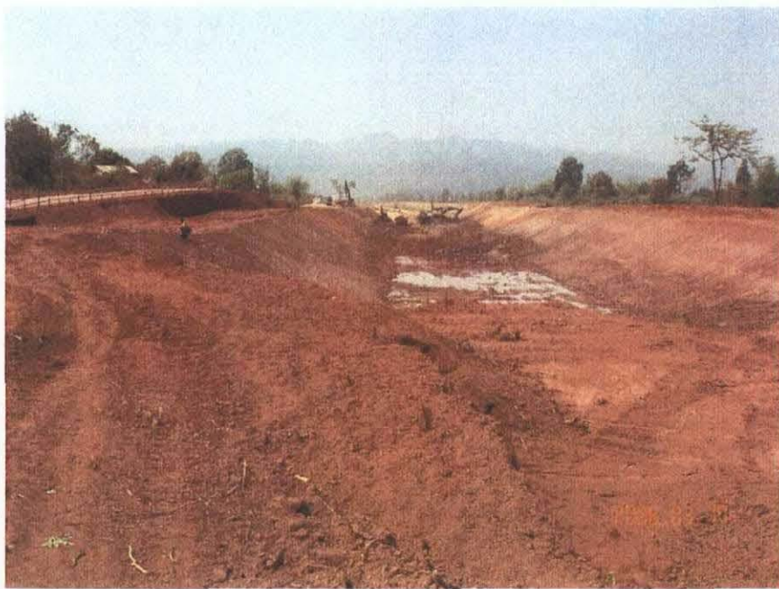
同上下流の放流水路の掘削風景。水路底幅 40m、放流量 340\text{m}^3 と計画されている。
