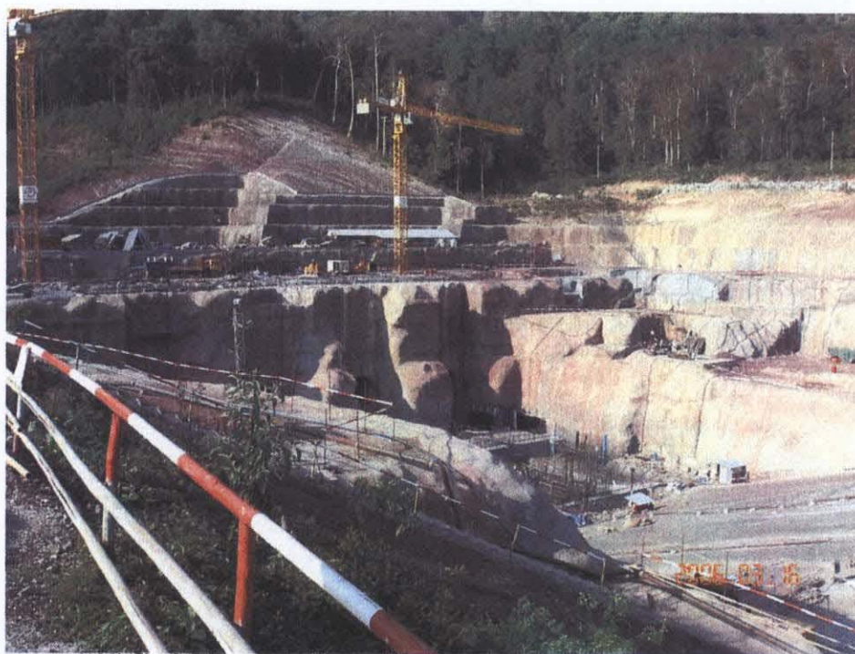
ナムツン 2 水力発電工事西松建設中の施設の状況 内径約 10m、延長 3.5km、標高差約 230m の導水路トンネル出口。
