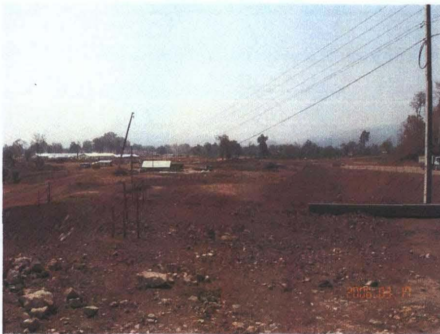
NT2 調整用ダム施設の建設風景。
