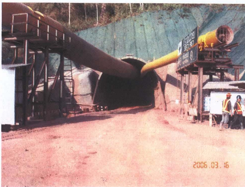
ナムツン 2 水力発電工事西松建設中の施設の状況、Access Adit, 馬蹄形トンネル、口径 7.7m
