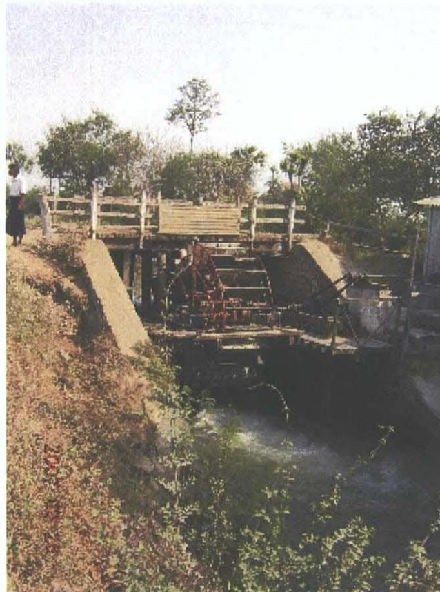
Phwint Hlang 村 灌漑水路落差工に設置されたマイクロ水力
