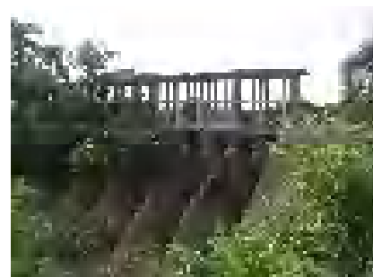
ポルポト水路は取水堰の機能低下から長年に亘り維持管理が行われていないため、通水断面が殆ど確保されていない。（プルサット州）
