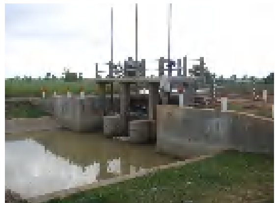
Damnak Ampil 堰下流の完成水路に設置された堰上げゲート
