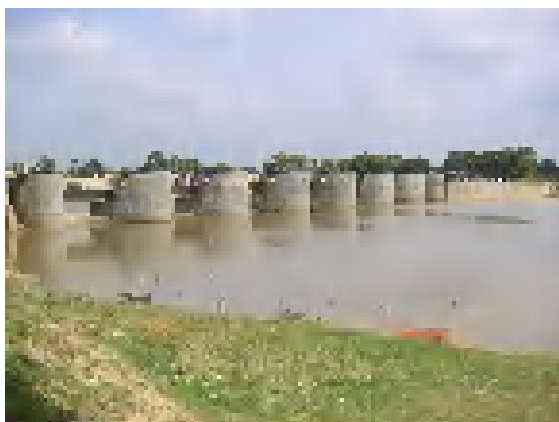
Damnak Ampil 堰は 2007 年 6 月に完成しており、乾期作における生産性向上が大きく期待される。
