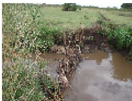
現地で入手可能な材料を利用した堰
