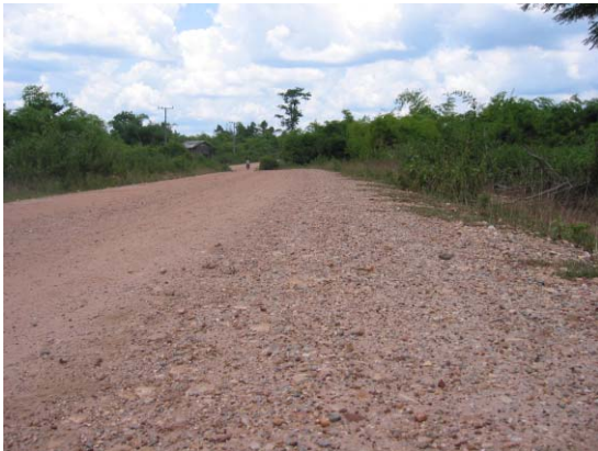
対象地域西側の改修された道路
