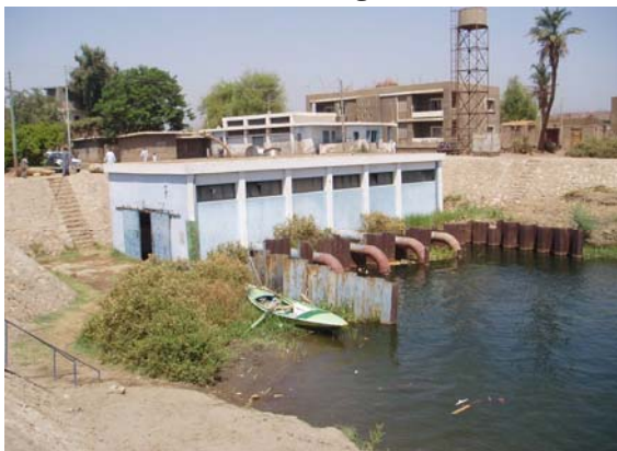
ポンプ場全景
