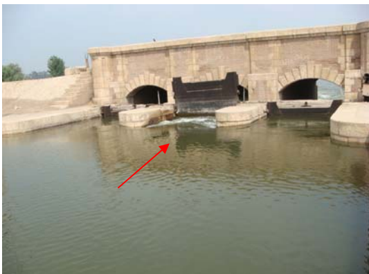
堰上流側全景
