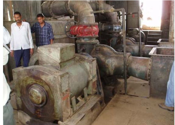
ポンプ場内部、老朽化が激しい
