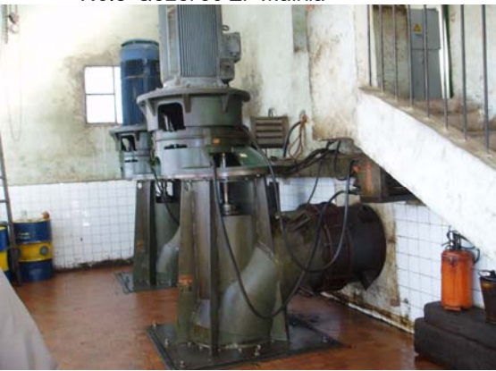
ポンプ場内部 No.9 Naga El-Saih
