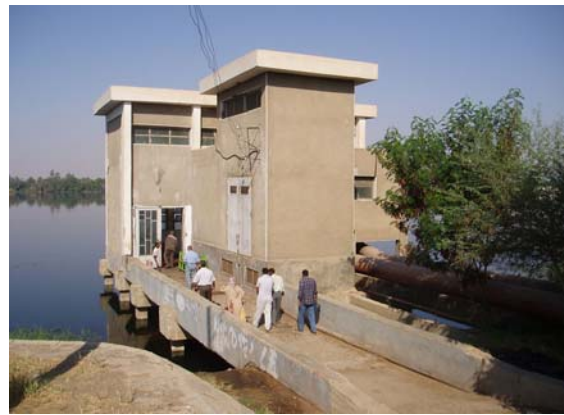
ポンプ場全景
