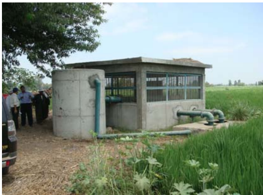
技プロ 末端ポンプ場
