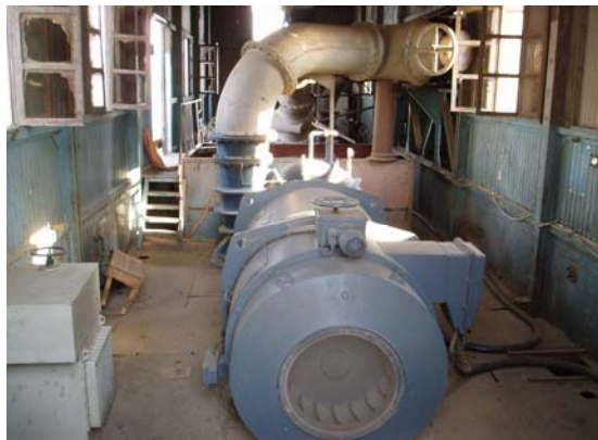
ポンプ場内部
