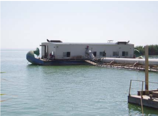
ポンプ場全景
