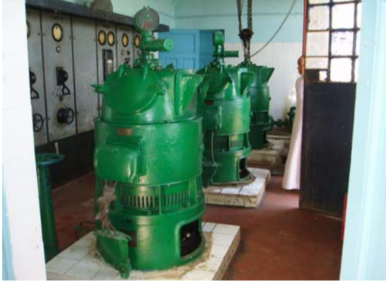
旧ポンプ場内部
