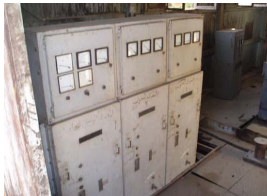
老朽化した操作盤
