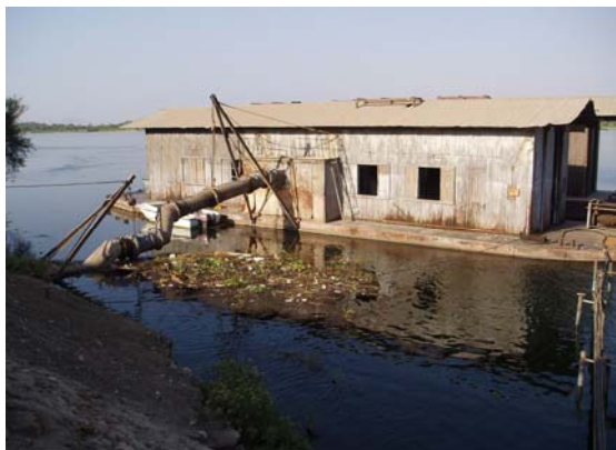
ポンプ場全景
