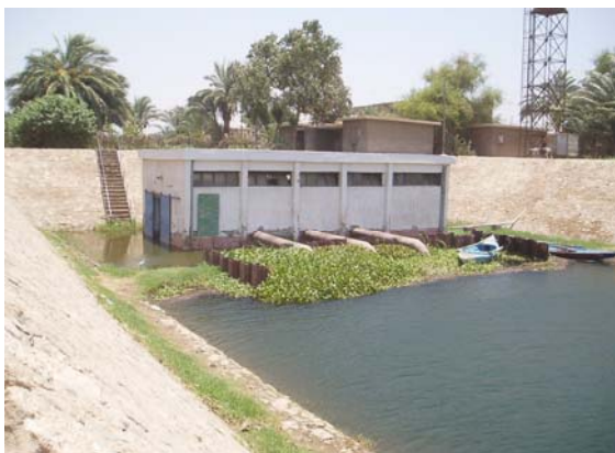
ポンプ場全景
