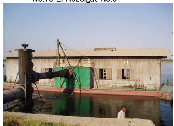
ポンプ場全景
