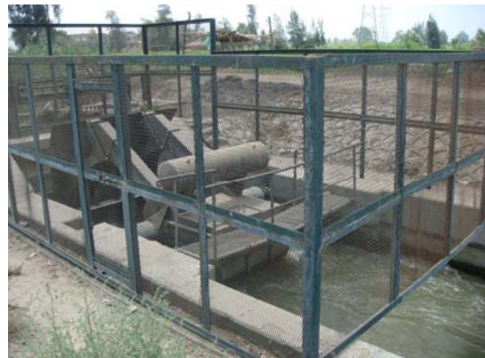
技プロ バハルヌール水路取水ゲート
