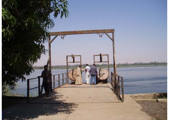
メンテナンス用クレーン設備
