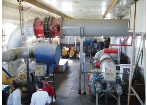
ポンプ場内部
