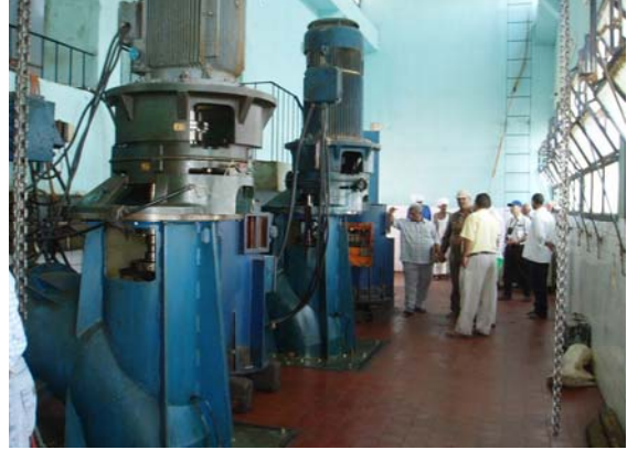
新ポンプ場内部
