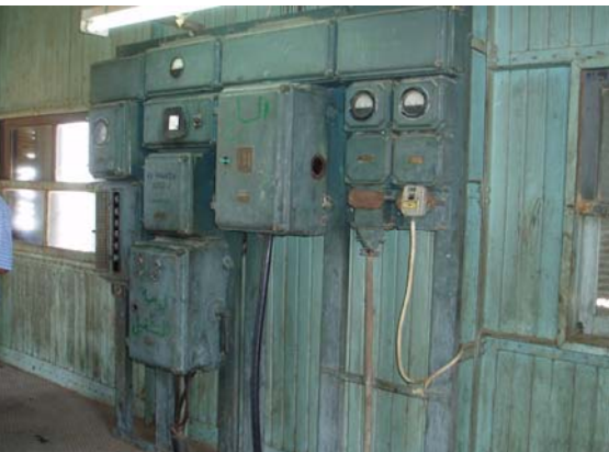
老朽化した操作盤
