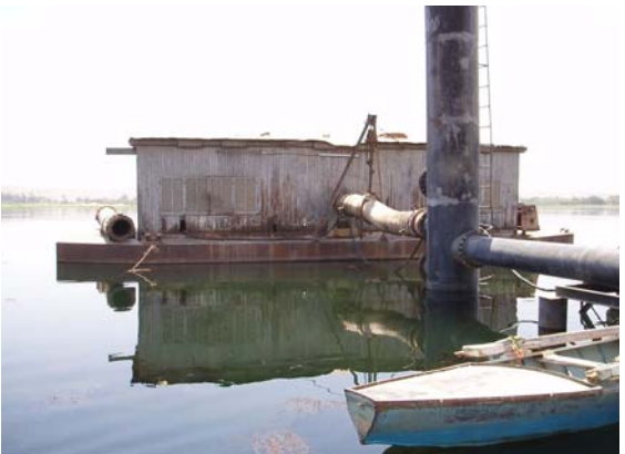
ポンプ場全景
