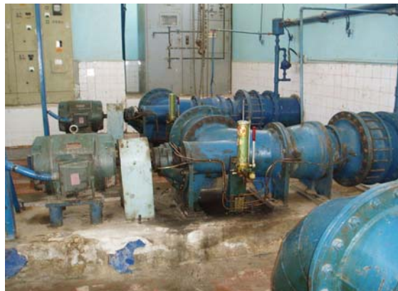
ポンプ場内部
