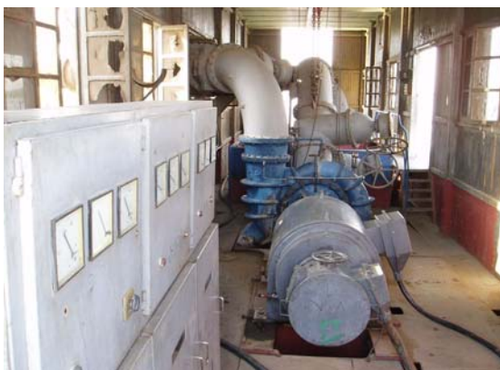
ポンプ場内部
