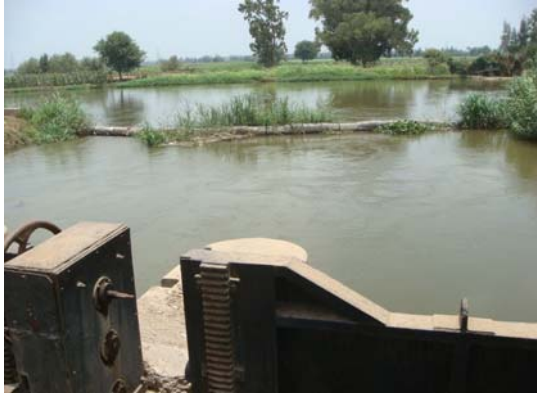
バハルシェビン幹線水路(向こう側)と バハルテラ2次水路(手前)
