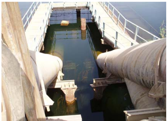
水中ポンプ方式取水パイプ
