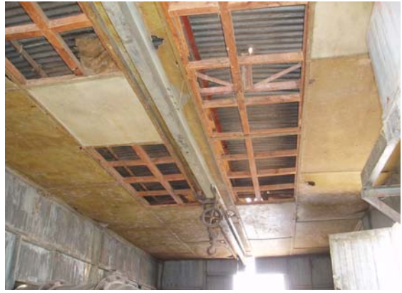
天井クレーン
