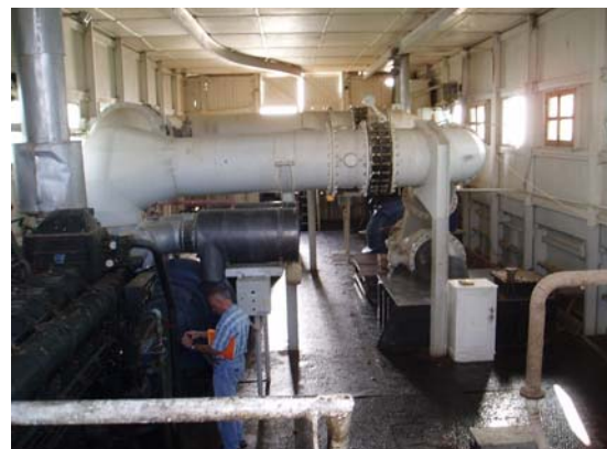
ポンプ場内部
