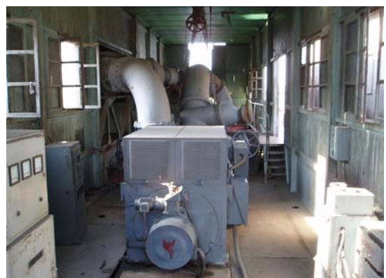
ポンプ場内部
