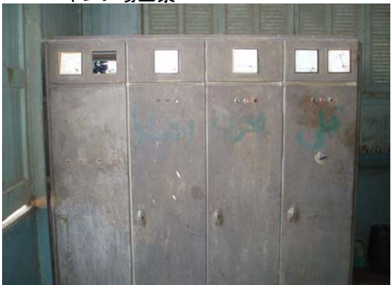
老朽化した操作盤
