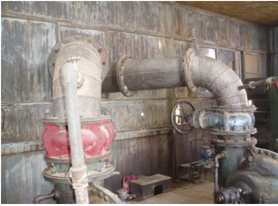
Discharge Pipe No.8 Gezeret El-Malkia
