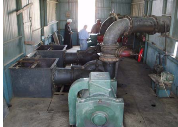
ポンプ場内部
