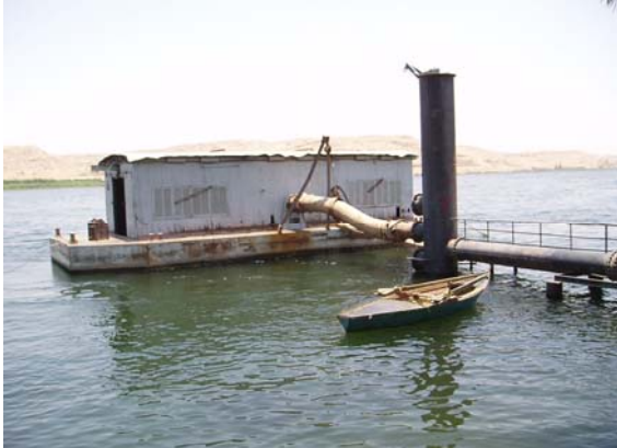
ポンプ場全景
