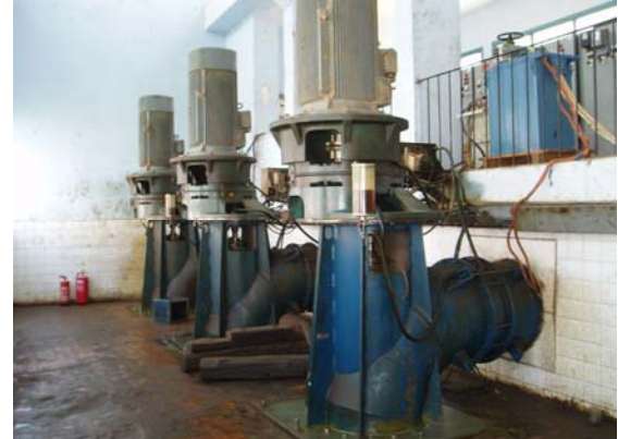
新ポンプ場内部
