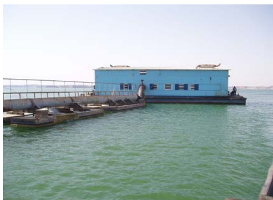
ポンプ場全景
