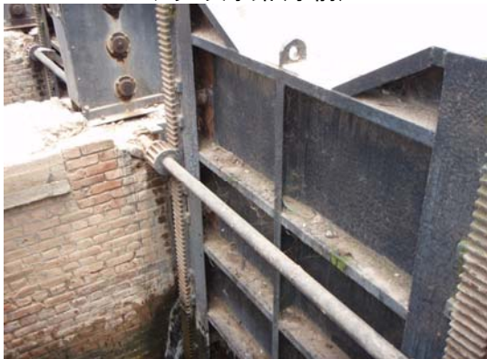
バハルテラ取水ゲート
