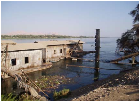
ポンプ場全景
