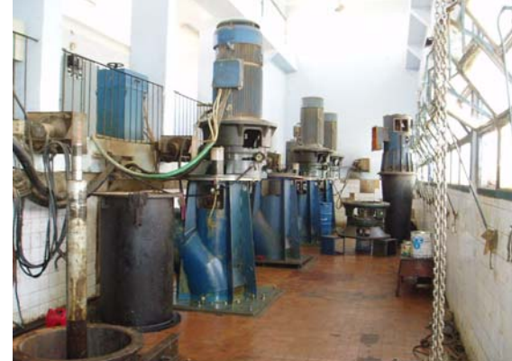
新ポンプ場内部
