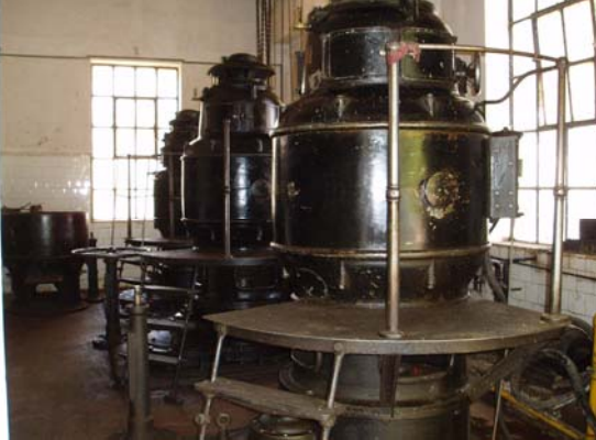
旧ポンプ場内部
