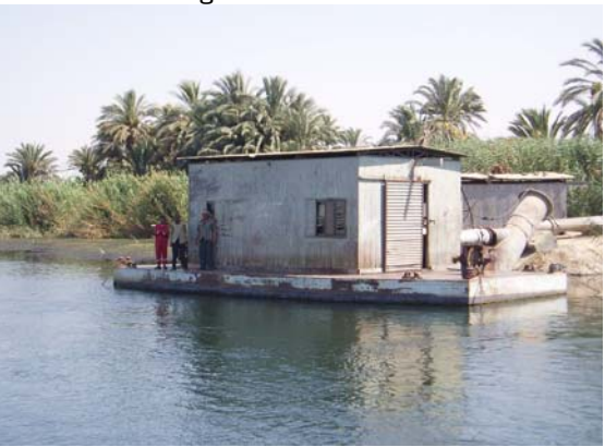
ポンプ場全景
