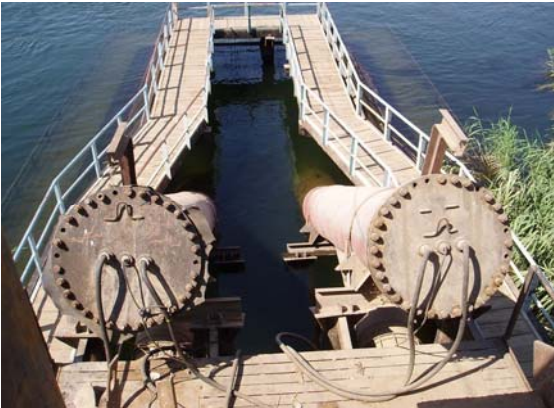
水中ポンプ方式取水パイプ
