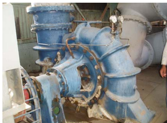
老朽化したポンプ
