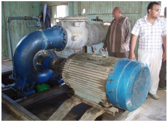
モーター及びポンプ
