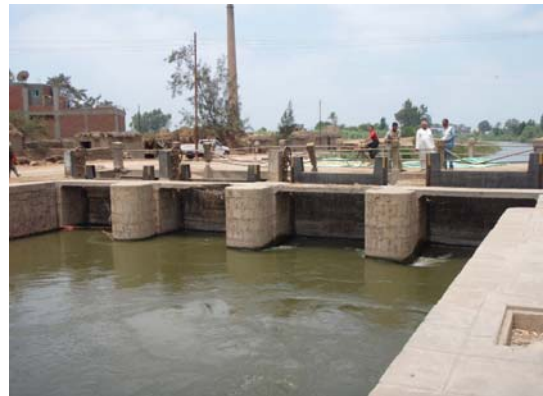
バハルテラ取水工
