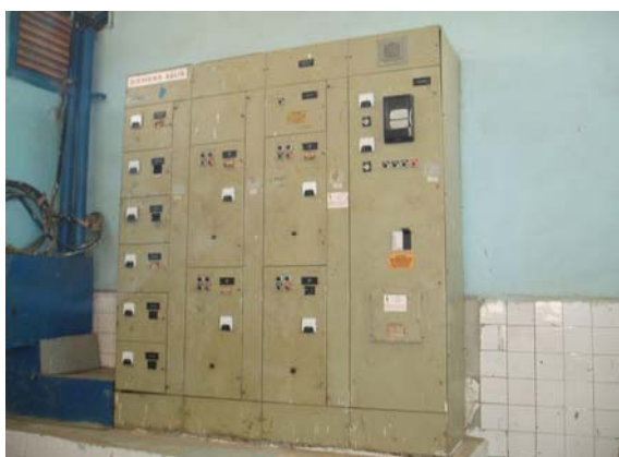
老朽化した操作盤
