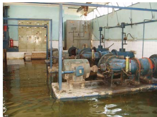
ポンプ場内部
