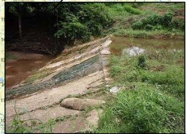
土砂が堆積した固定堰
