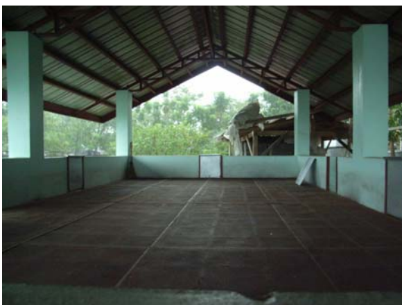
6t 平型乾燥機 (フィルラリス設計タイプ) (Hollow blocks 利用)
