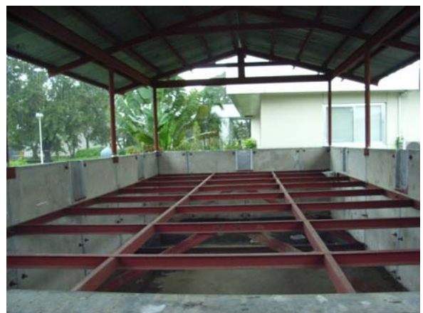
6t 平型乾燥機 (BPRE 設計タイプ) (プレキャストコンクリート利用)
