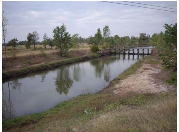
Mun 川支流、Sieo Noi 川の取水堰
