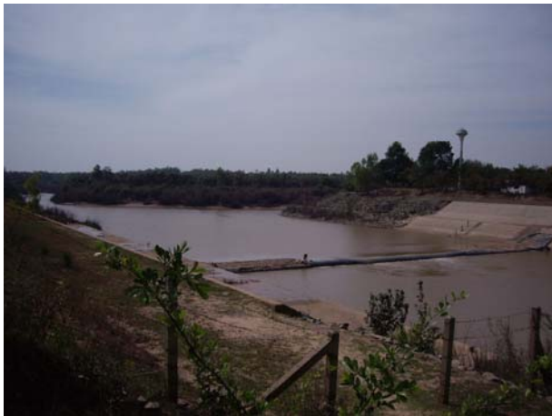
Mun 川大支流、Lam Chi 川の Kok Ja ラバー取水堰
