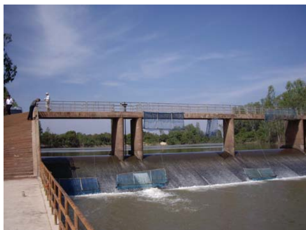
Mun 川支流、Huai Samran 川の Mong Muang 取水堰 (RID 建設)
