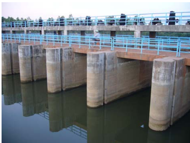
Mun 川支流、Huai Samran 川の取水堰 (DWR 建設)
