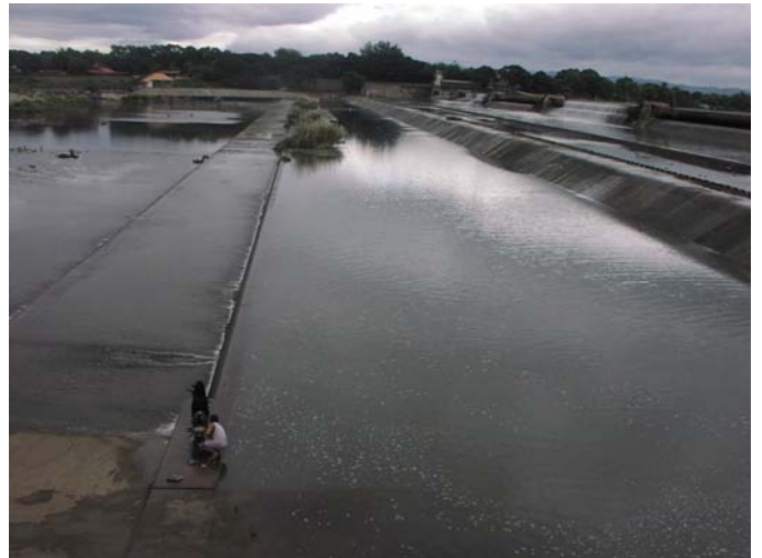
Angat ダム(1998 年改修)の下流エプロン
