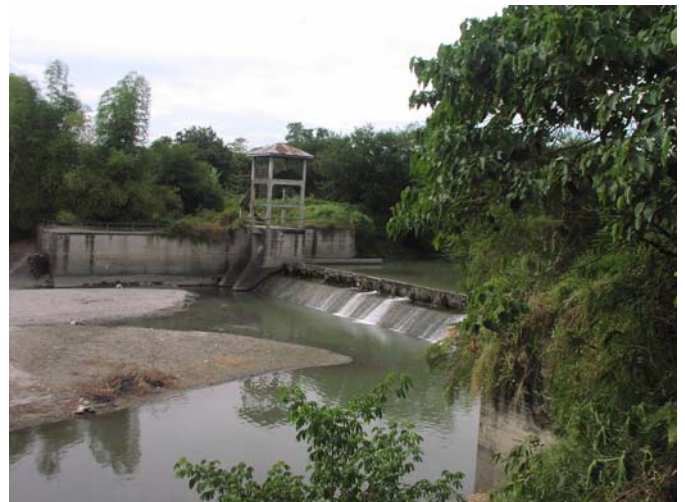
河床低下対策として板による嵩上げ(仮設)
