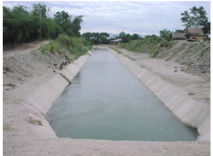
取水口直下の幹線水路、沈砂池はない
