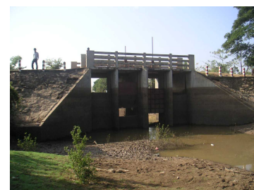
水門の調整により雨期に増水した河川水を貯留し、灌漑農業を行う。
