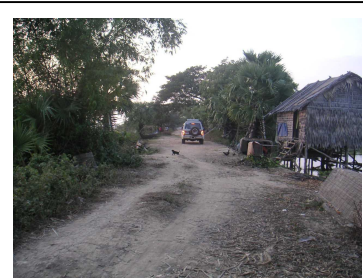
DANIDA 支援により改修された 堤防兼農道である。 トウンヌップ 78 灌漑地区堤防
