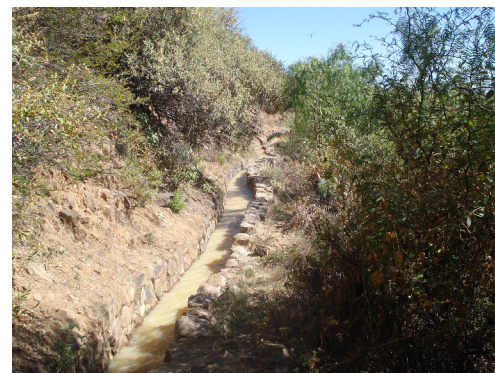
下流Hydoro Canalの護岸状況。地区内に入ると土水路に変わる。
