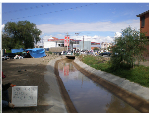
STA.0+400付近の完成状況。撮影日:2008年10月27日
