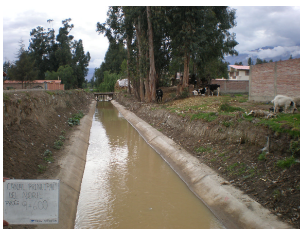
STA.9+600付近の完成状況。撮影日:2008年10月30日
