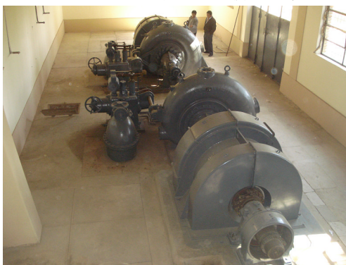
発電所の中の状況。水車、発電機は一見良好に見えるが、老朽化が激しい。
