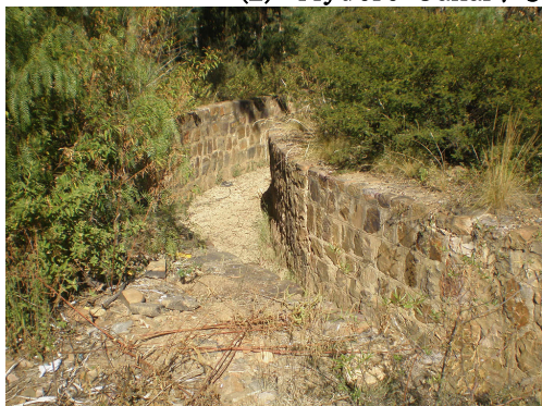
Hydoro Canal上流部の護岸状況。非常に堅固で、十分現況利用が可能
