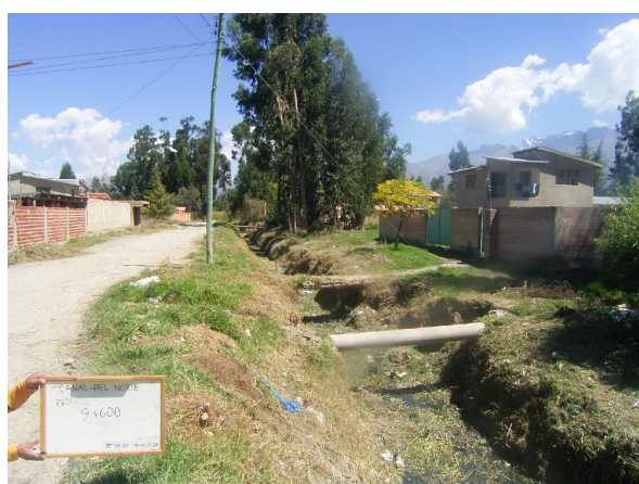
STA.9+600付近の現況。撮影日:2008年4月4日
