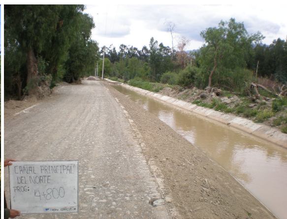
STA.4+800付近の完成状況。撮影日:2008年10月29日
