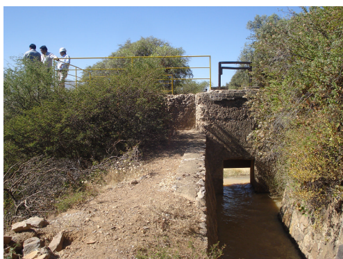
分土工から下流のHydoroかんがい水路への流出口の状況
