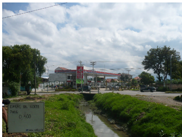
STA.0+400付近の現況。撮影日:2008年4月4日
