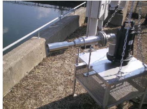
図-1 マイクロバブルインジェクター
