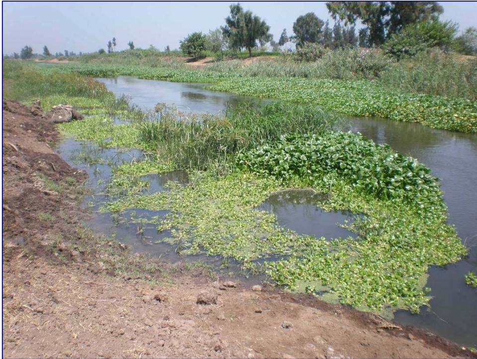
バハルエルヌール地区 No.4 幹線排水路：ホテイアオイが繁茂し、一定の排水浄化がなされている（但し、これらが腐敗するまで放置されると新たな汚濁負荷となるので注意が必要である）。
