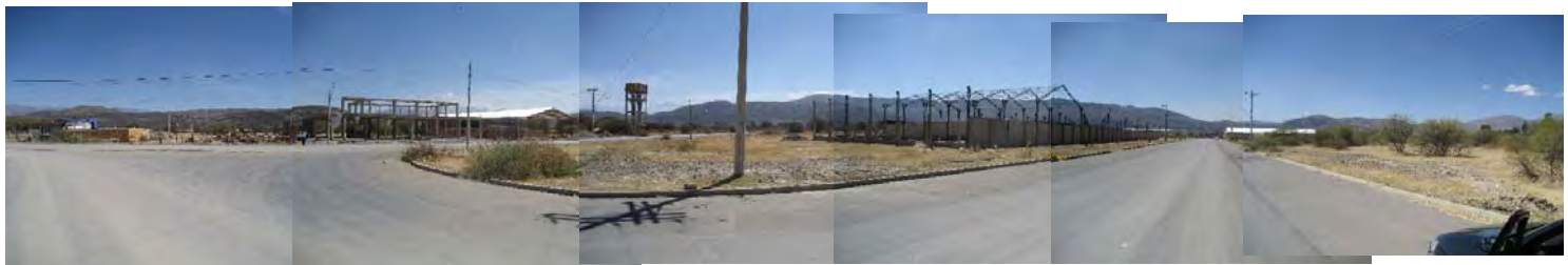
工業団地の整備状況（1期工事地区）
