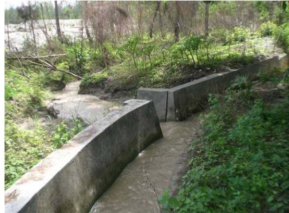
図-4.5 ARPにより改修された水路
