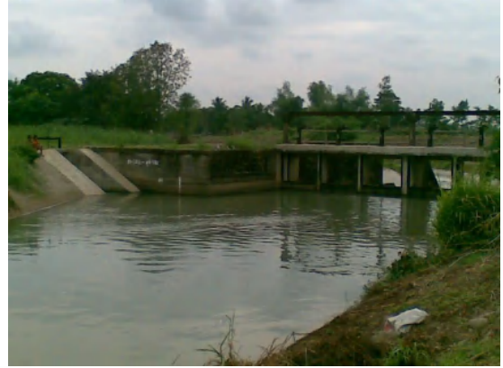
幹線水路チェックゲート
