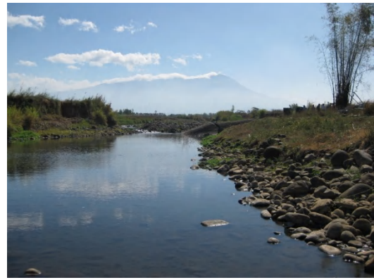
Marakandang 川取水堰候補地サイト
