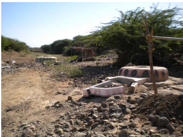
アンブリ ワジ両岸に広がる灌漑農地地区（450戸、平均農地面積は約1.5ha） ワジの中のコンクリートで保護した浅井戸から、個人ごとにホンプで灌漑用水を送水している。
