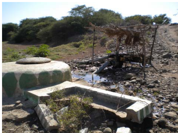
アンブリ ワジ両岸に広がる灌漑農地地区（450戸、平均農地面積は約1.5ha） ワジの中のコンクリートで保護した浅井戸から、個人ごとにホンプで灌漑用水を送水している。
