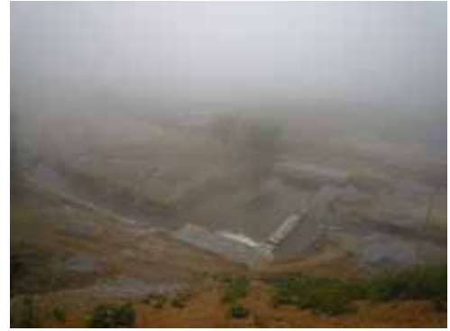
バック・ナム郡ジャック・ヒュウ (Giac Hieu) 村で建設中の堰。
