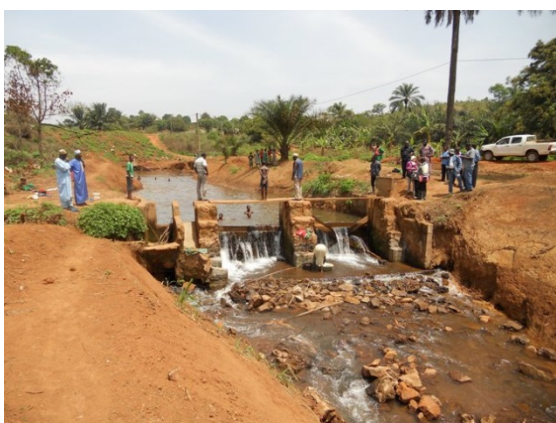
改修された分水工 （西部州 ヌーン県 クタバ地区）
