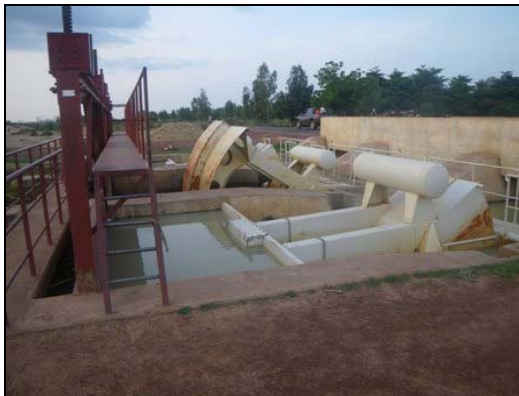
写真：幹線水路の分土工
