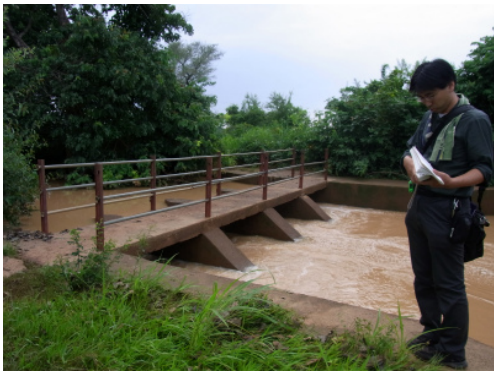
Kamalesirakoro 地区での流出堰の視察
