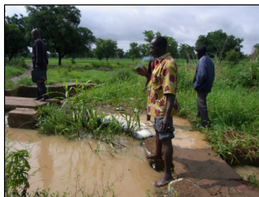
写真：現況の堰の様子
