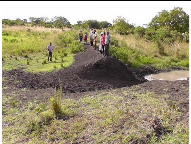
Apedu Dam：堤体の中央部が最近の洪水により流されてしまっている。
