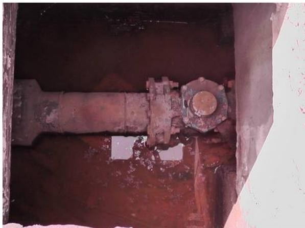
取水工に付帯しているバルブ制御装置(上流側の取水工)
