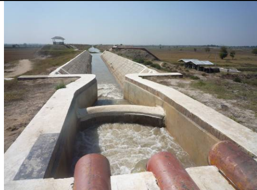
⑩ 吐出口 (Yakyi Pauk ポンプ場) : 水頭差は約 20m、ポンプアップされた水は、重力流下で次のポンプ場まで流れる。
