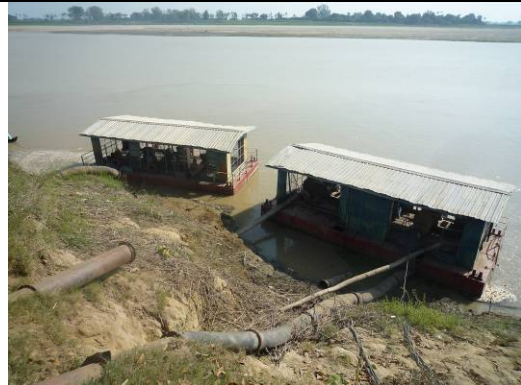
⑭ Chit Thu ポンプ場 (ヤサギョー) : Chit Thu ポンプ灌漑のポンプ、水源はチンドウィン川。メンテナンスの為、停止中。
