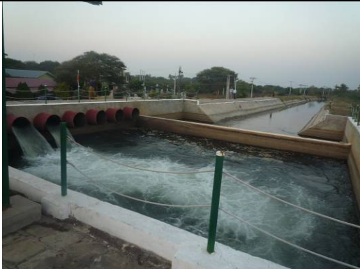
⑬ 揚水後 (Lawkananda ポンプ場) : 重力流下とポンプによる揚水を繰り返し、高低差 100m、全長 9.2km の主水路を進む。
