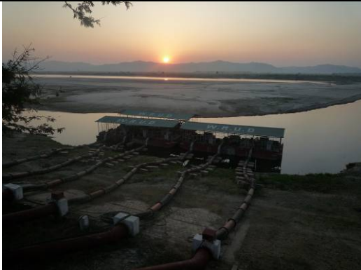
⑪ Lawkananda ポンプ場 (ニャンウー) : 水資源利用局の Lawkananda ポンプ灌漑 (7 段階揚水) のメインポンプ。
